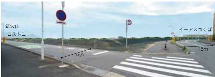
現場写真①
