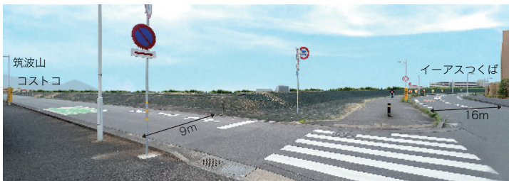
現場写真①
